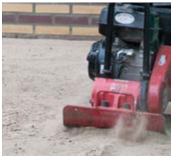
1. VERDICHTEN VAN HET ZANDBED
