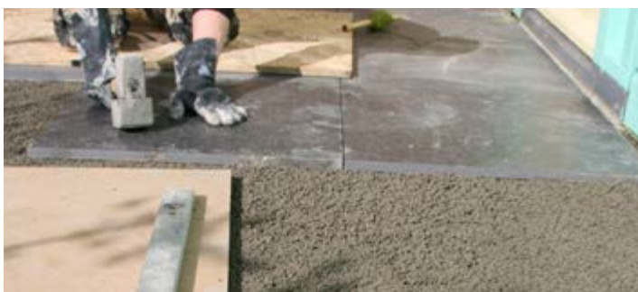
6. INKLOPPEN VAN DE TEGEL IN DE DRAINAGEMORTEL
