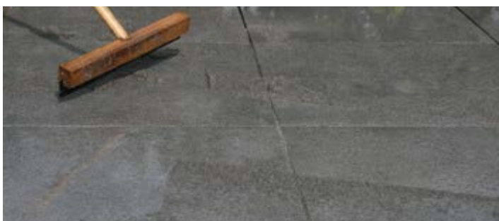
7. BESTRATING INVOEGEN MET BOSTIK HOVENIERS VOEGMORTEL 1C FLEX
