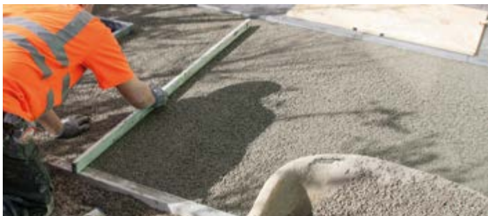
3. AANBRENGEN VAN DE DRAINAGEMORTEL EN AFREIEN TOT EEN LAAG DIKTE VAN 4 CM
