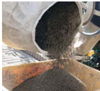
2. MIXEN BINDMIDDEL EN SPLIT IN DE BETONMOLEN
