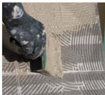
5. AANBRENGEN VAN DE LIJM OP DE ONDERKANT VAN DE TEGEL
